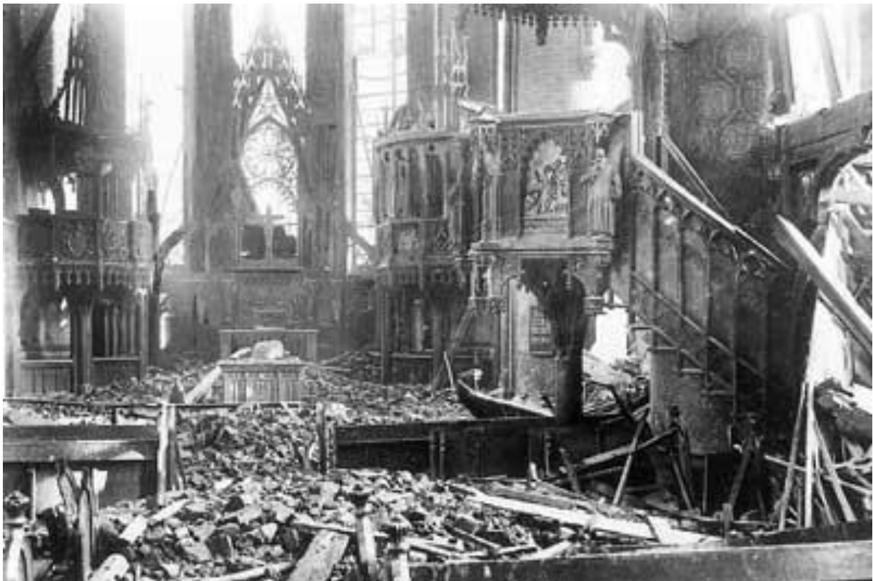
Innenraum nach Osten mit den Resten der neugotischen Ausstattung, Aufnahme 1945/46
